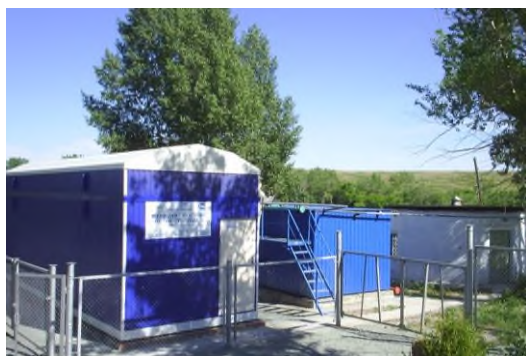
КОС производительностью 100 м 3 /сут для базы отдыха ОАО «Гайский ГОК»
