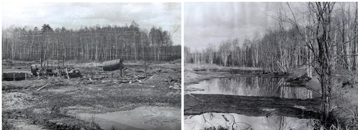
Рис. 3. Состояние буровых площадок после окончания буровых работ. Воронцовское месторождение (Фото: В.М. Невзорова, 1971 г.).
