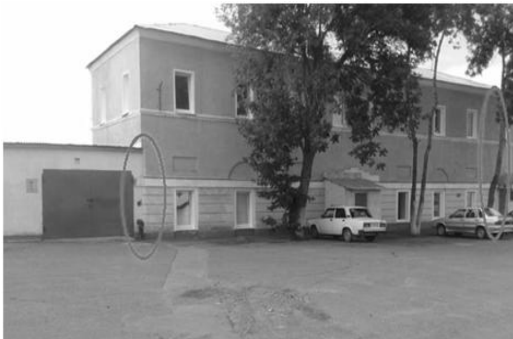
Рис. 1. Обследуемое здание (г. Оренбург, ул. Набережная 29).
